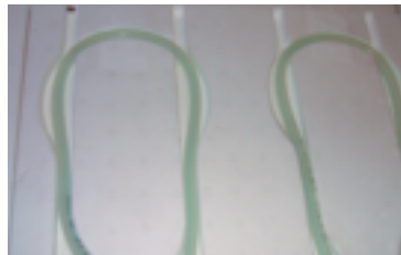
溝に沿って配管
